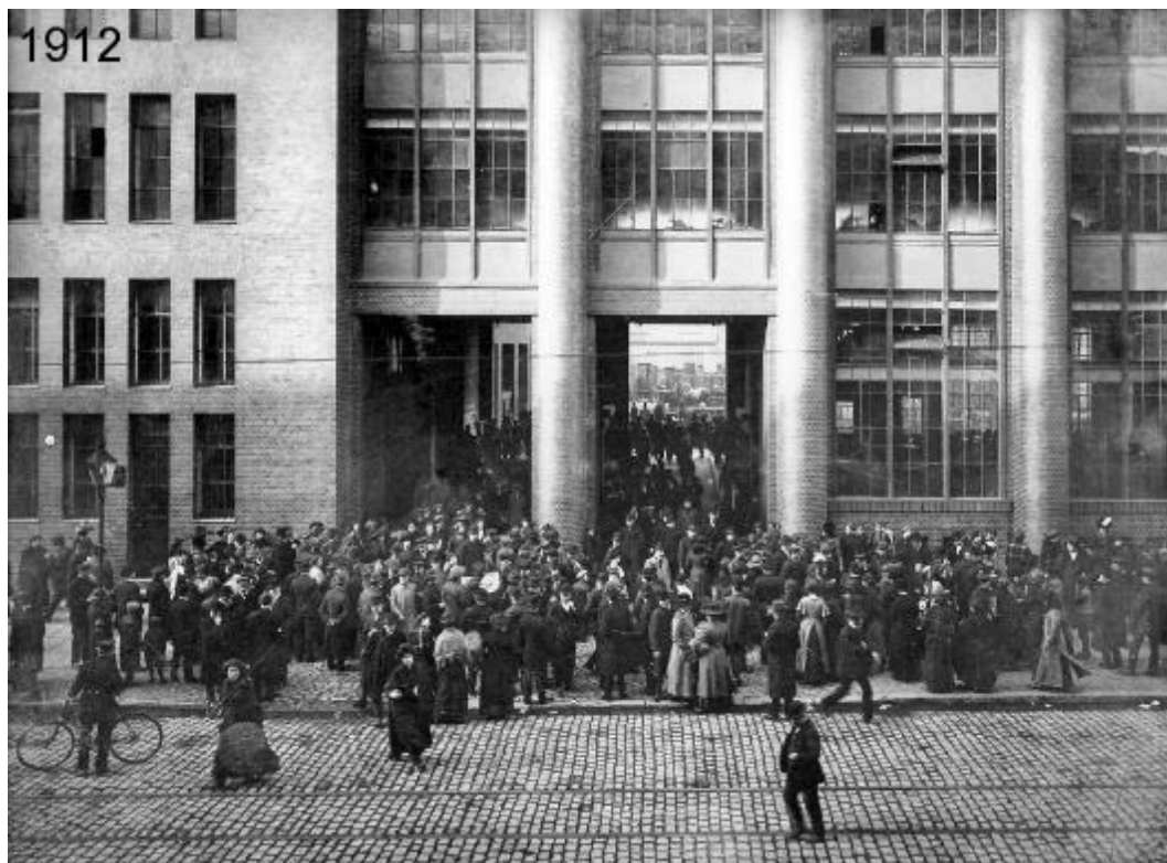
Abbildung 11: Das ehemalige Werkstor Nr. 3 in der Kleinmotorenfabrik an der Voltastraße (heute nicht mehr vorhanden)
